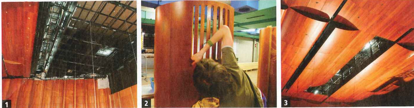
1. DÉFICIENCE. Le chantier a mobilisé une cinquantaine de professionnels pendant quatre mois. 2. PATIENCE. Des menuisiers ont scié et poli à la main 5 kilomètres de rainures dans les parois boisées de la salle. 3. INVESTISSEMENT. Les travaux ont coûté 7,5 millions de francs, pour une rénovation invisible, ou presque, pour le profane.
